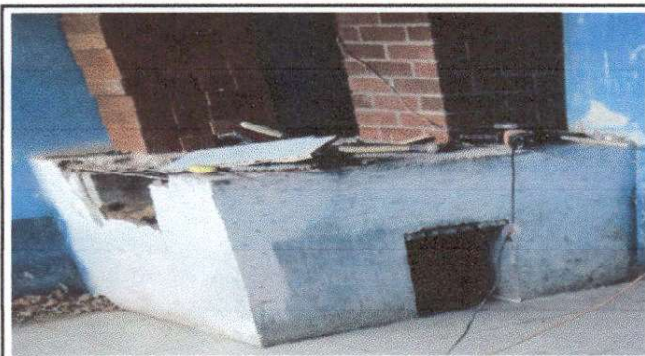
Foto 3: Reparación de estufa
