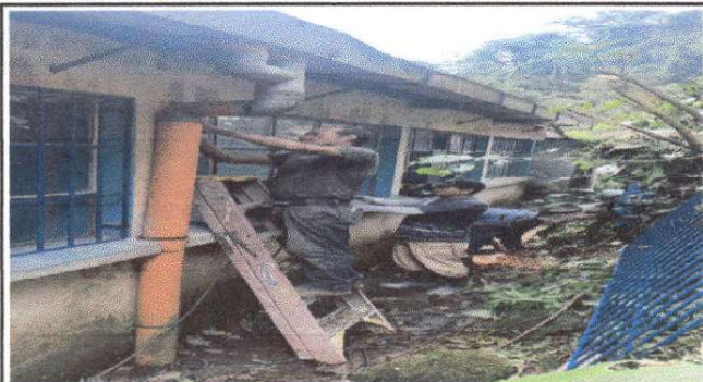
Foto 1: Sustitución de balcones
