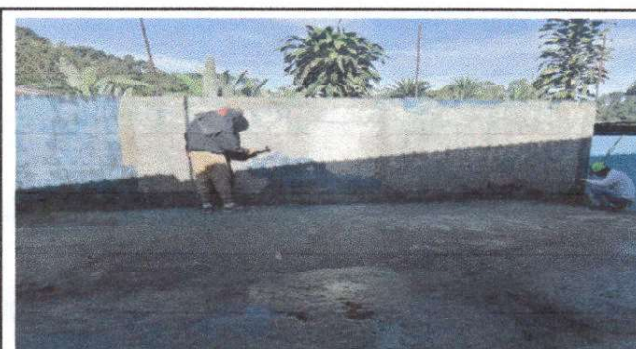
Foto 6: Repello de muro
