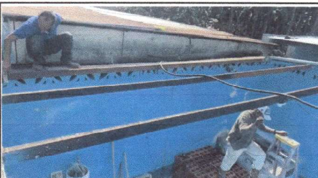
Foto 4: Cambio de laminado
