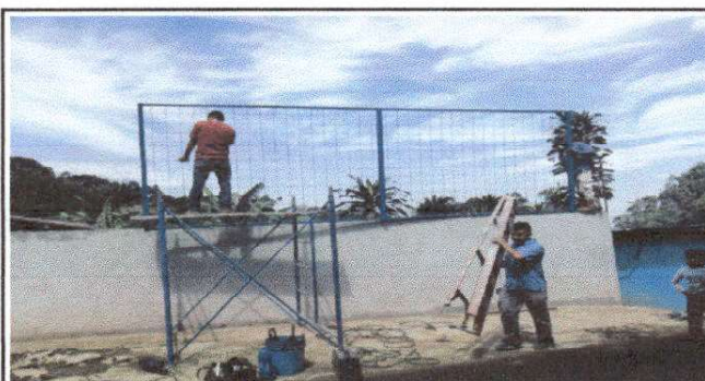
Foto 5: Sustitución de enmallado
