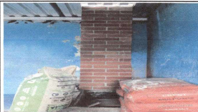
Foto 2: Reparación de Chimenea
